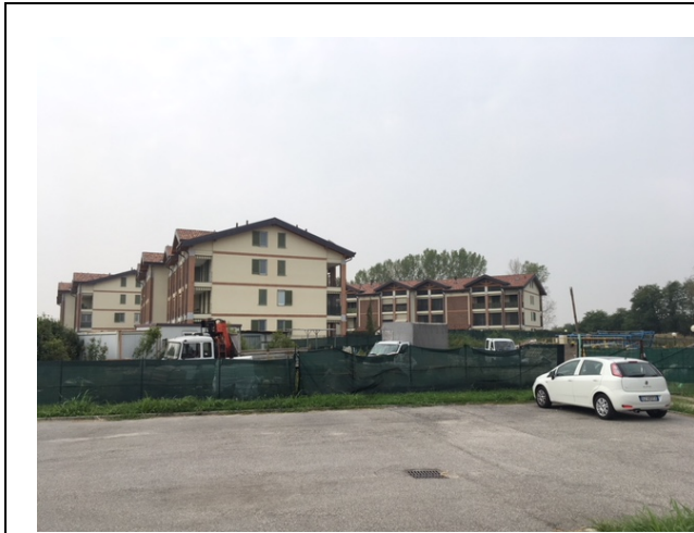
Vista da area parcheggio su Via Falcone
